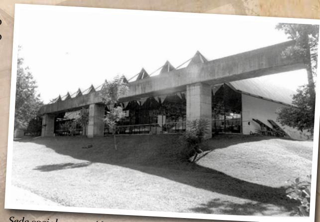
Sede social construída no final dos anos 70, com características diferenciadas.
