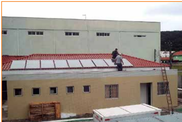
Em Caiobá, instalação de placas que captam luz solar para aquecimento da água.
