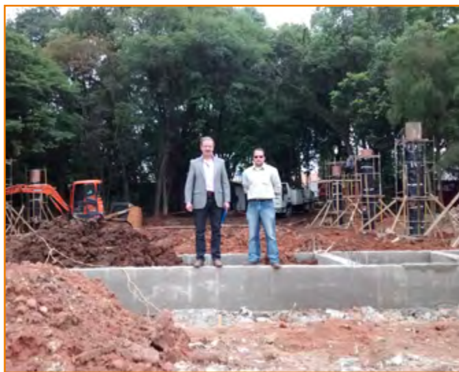
Presidente e engenheiro nas obras da academia: fase de estruturação.
