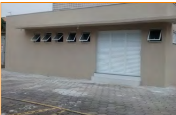
Almoxarifado em Caiobá: armazenagem mais adequada de materiais.
