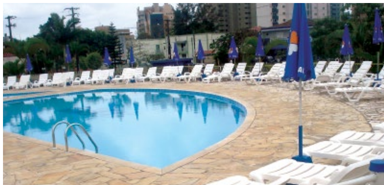
Piscina da praia: ajustes nos azulejos e colocação de corrimão.
